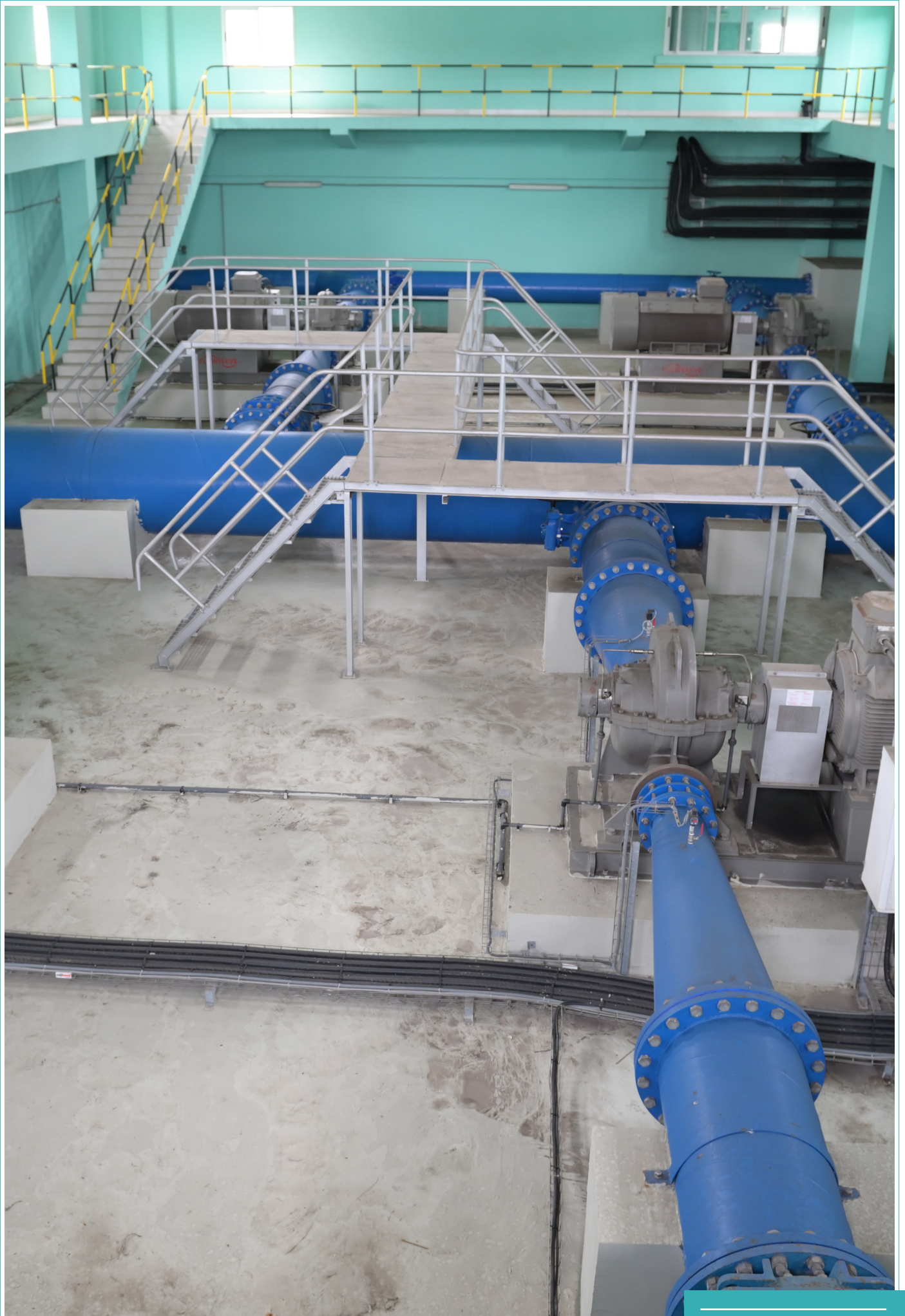
Usine de reprise de Port Bouet
